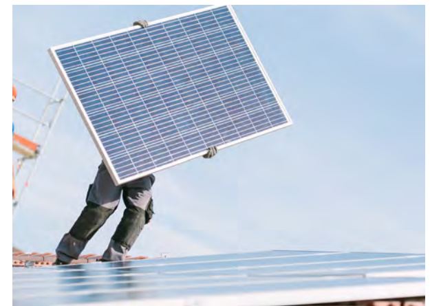
Ausbau von Solarenergie durch PV-Anlagen
